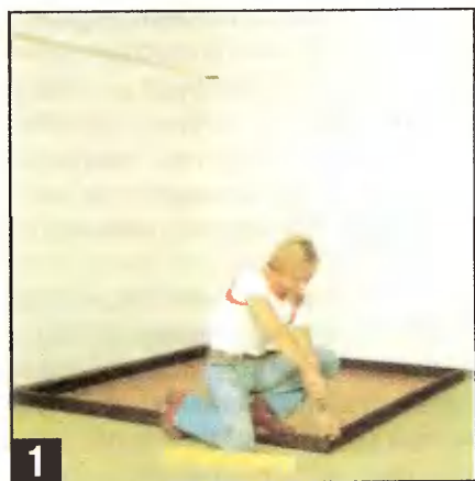
На выбранном для сауны месте укладывают и, после проверки горизонтальности, прикрепляют к полу брусья основания.
