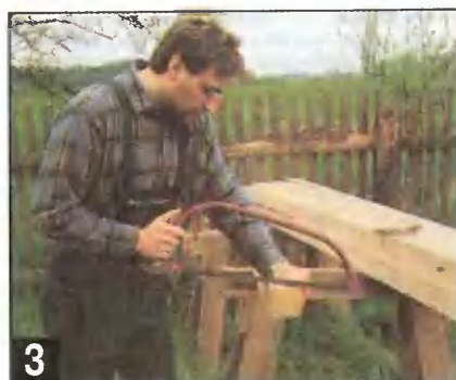
3 Нижнюю обвязку делают из бруса сечением 100х100 мм, лаги — из бруса сечением 80х80 мм. Разметку при распиловке длинного бруса на детали обвязки делают возможно точнее.
