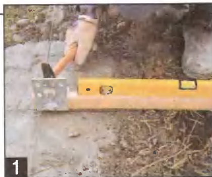
1 Анкерную закладку выравнивают по высоте сразу после заливки бетоном фундаментной опоры. Анкер легко притопить до нужного уровня в жидком бетоне легкими ударами молотка.
