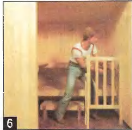
6 Устанавливают ограждение электропечи-каменки (противопожарный экран и защитную решетку) и приглашают для работы электрика.
