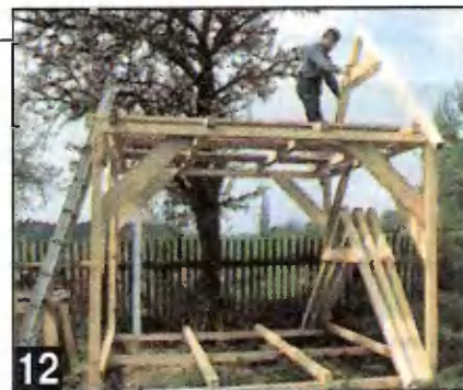
12 Уложив на каркас фасадных стен брусья перекрытия, а на них — доски временных мостков, приступают к установке стропил крыши. Первыми выставляют крайние стропильные фермы.
