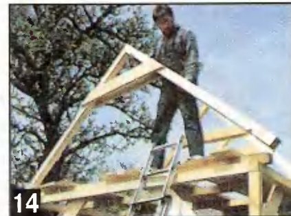
14 Вторую ферму на противоположной стороне устанавливают как показано на фото 13. Между верхними углами крайних стропил натягивают шнур для облегчения точной установки последующих.
