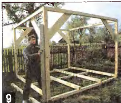
9 Прежде чем продолжить работу, нужно еще раз проверить, что каркас домика имеет правильную форму, а стены стоят вертикально. На этом этапе ошибки можно еще исправить.
