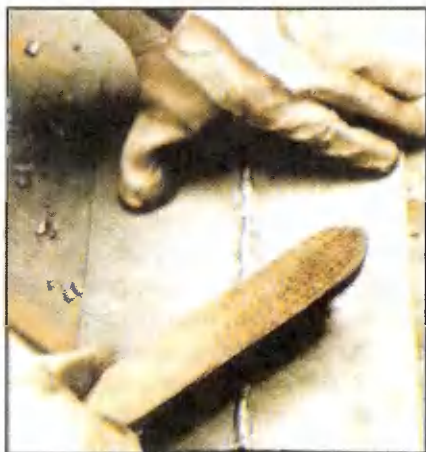
После удаления проволочной щеткой остатков шлака и загрязнений шов и прилегающие к нему места выглядят блестящими.
