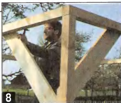
8 Кроме металлических накладок дополнительную прочность каркасу стен придают крепежные раскосы из досок. После их установки брусья, временно подкрепляющие стойки, снимают.
