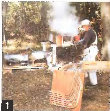
1 Первая партия пропаренных реек уже установлена в шаблоне.
