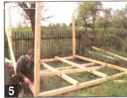
5 Сборку каркаса стен начинают с установки угловых стоек. Соединяют стойки с обвязкой металлическими скрепляющими элементами.
