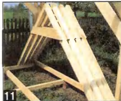
11 Составив стропильные фермы на брусьях нижней обвязки друг около друга, легко убедиться, что они имеют одинаковые размеры и форму.
