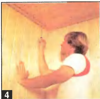
4 Для дополнительного уплотнения шва между стенами и потолком в угол шурупами прикрепляют потолочную галтель.
