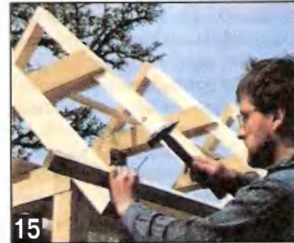
15 После выверки положения стропил, их скрепляют по ригелям рейкой. Начиная снизу, гвоздями прибивают рейки обрешетки крыши.
