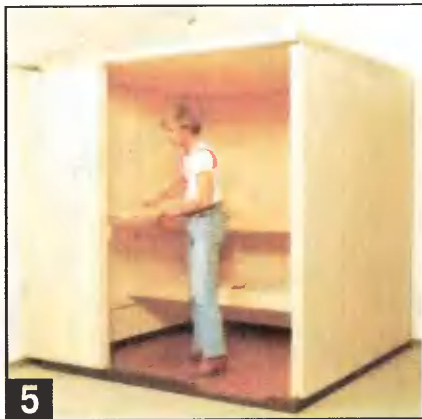
5 На настенные рейки ставят лежаки. Их не прикручивают, чтобы во время уборки кабины можно было легко снять.
