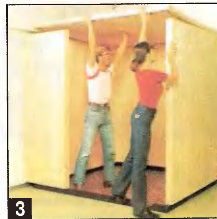
Сверху на стены плотно без щелей укладывают потолочное перекрытие.
