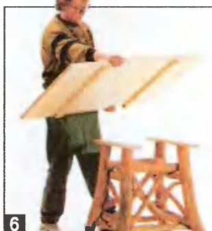
6 Столешницу вместе с поперечными обвязками также следует заменить.
