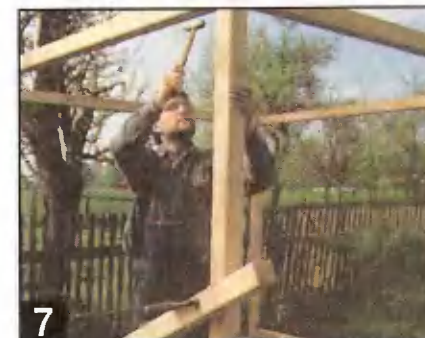
7 Выставленные по отвесу в вертикальное положение стойки подкрепляют прибитым на угол брусом. Сверху на угловые стойки укладывают верхние балки каркаса фасадных стен, а балки каркаса боковых стен прикрепляют встык.
