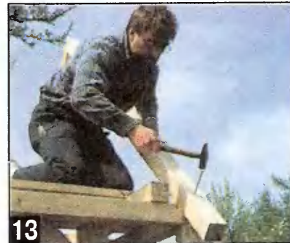
13 Для устойчивости стропильной ноги в затяжке (горизонтальный брус), ее врубают зубом или шипом и крепят гвоздями.
