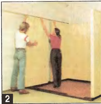
Начиная от дальнего угла, последовательно одну за другой устанавливают стеновые панели, тщательно подгоняя их в стыках.
