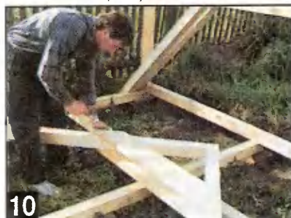
10 Используя горизонтально уложенные лаги, раскладывают детали стропил. Два накладных ригеля при вершине стропильной фермы придают конструкции дополнительную прочность и жесткость.
