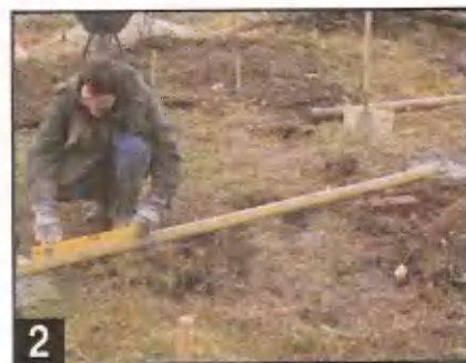
2 Контролируют горизонтальность бруса, уложенного в башмак металлического анкера. На этой стадии легко исправить неточности.
